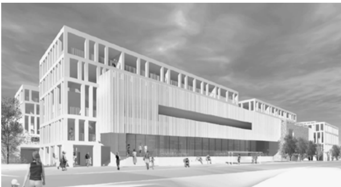
Image de synthèse du projet de densification de la parcelle Coop (source : Maison d'architecture Serge Gard)
